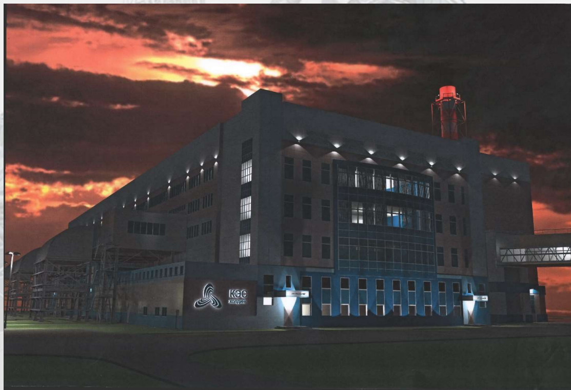
Новокуйбышевская ТЭЦ-1 с установленной мощностью по парогазовому циклу 200 МВт, г. Новокуйбышевск
