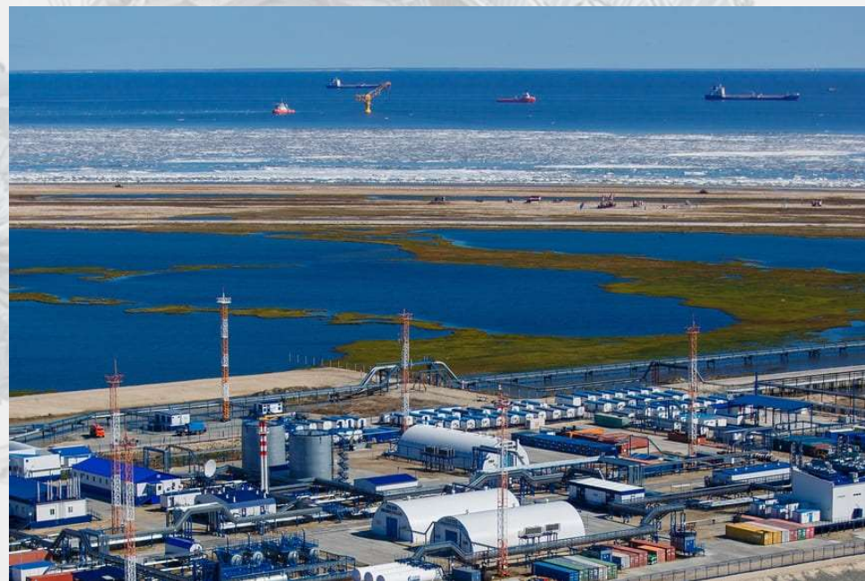
ГТЭС Новопортовского нефтегазового месторождения, ЯНАО
