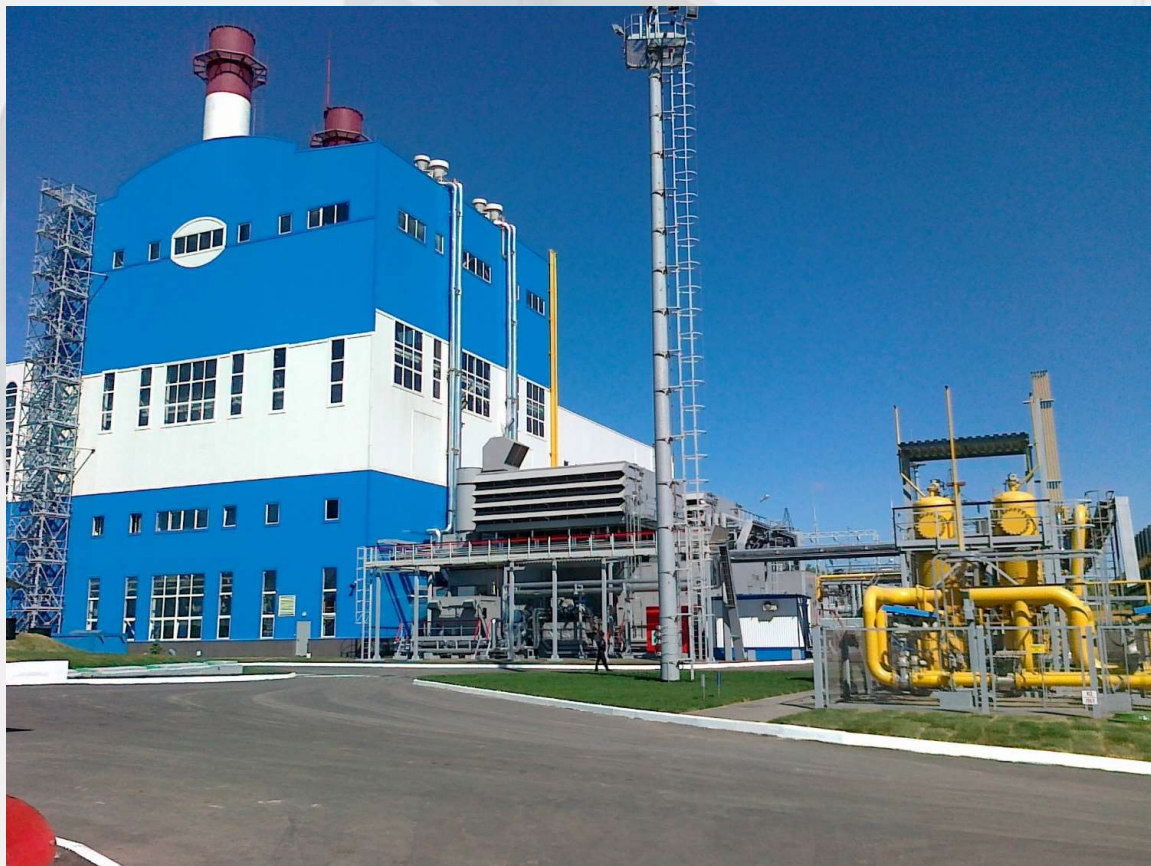
Северо-западная котельная ПГУ-115 МВт, г. Курск
