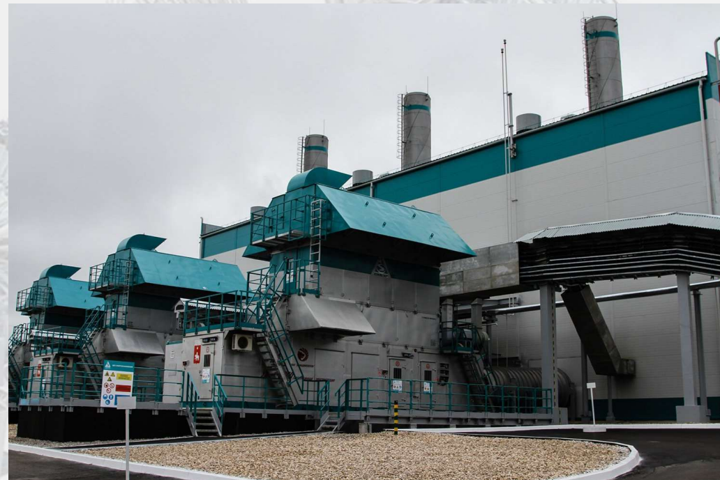
ЗАО "Сибур-Химпром" Строительство энергокомплекса установленной электрической мощность 18 МВт, тепловой - 27 гКал/час, г. Пермь
