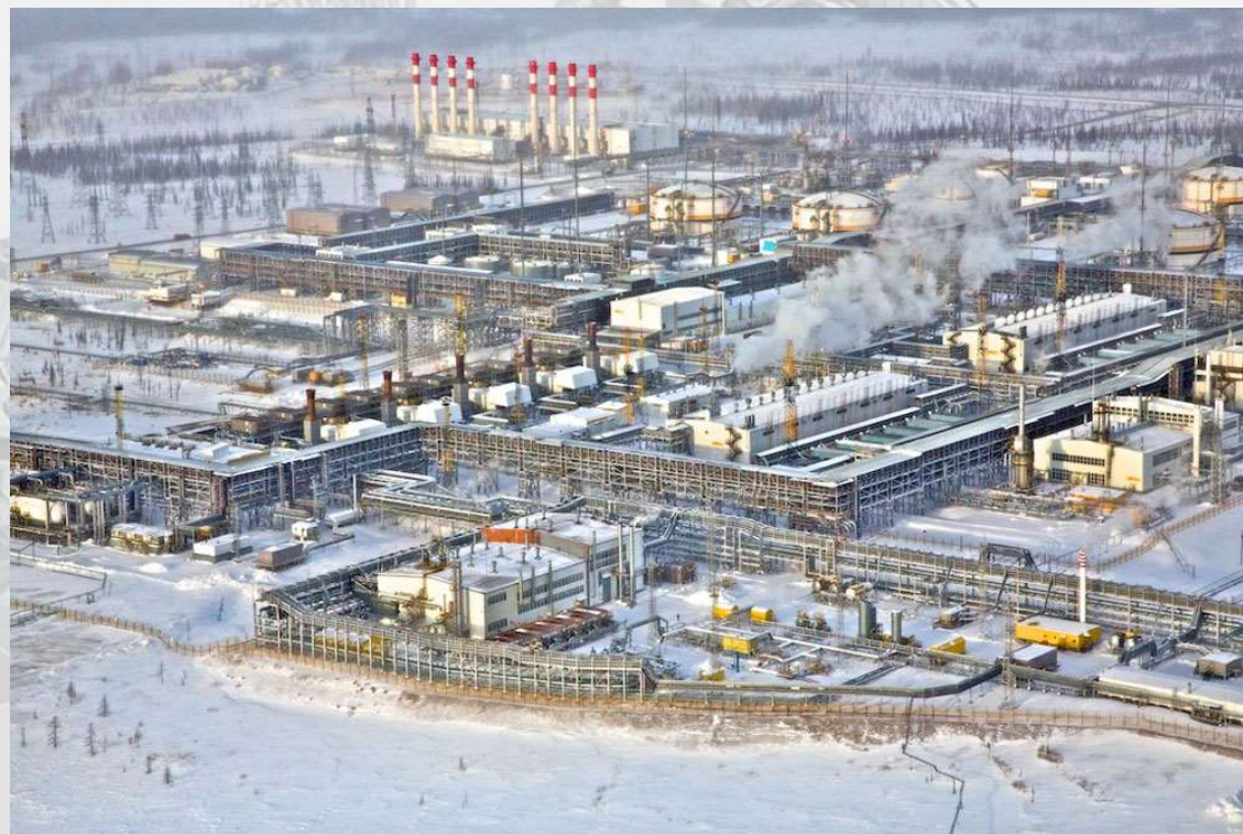
РН-Ванкор 2-я очередь ГТЭС СН Ванкорского нефтяного месторождения установленной электрической мощностью 103,2 МВт, тепловой – 132 МВт, ЯНАО
